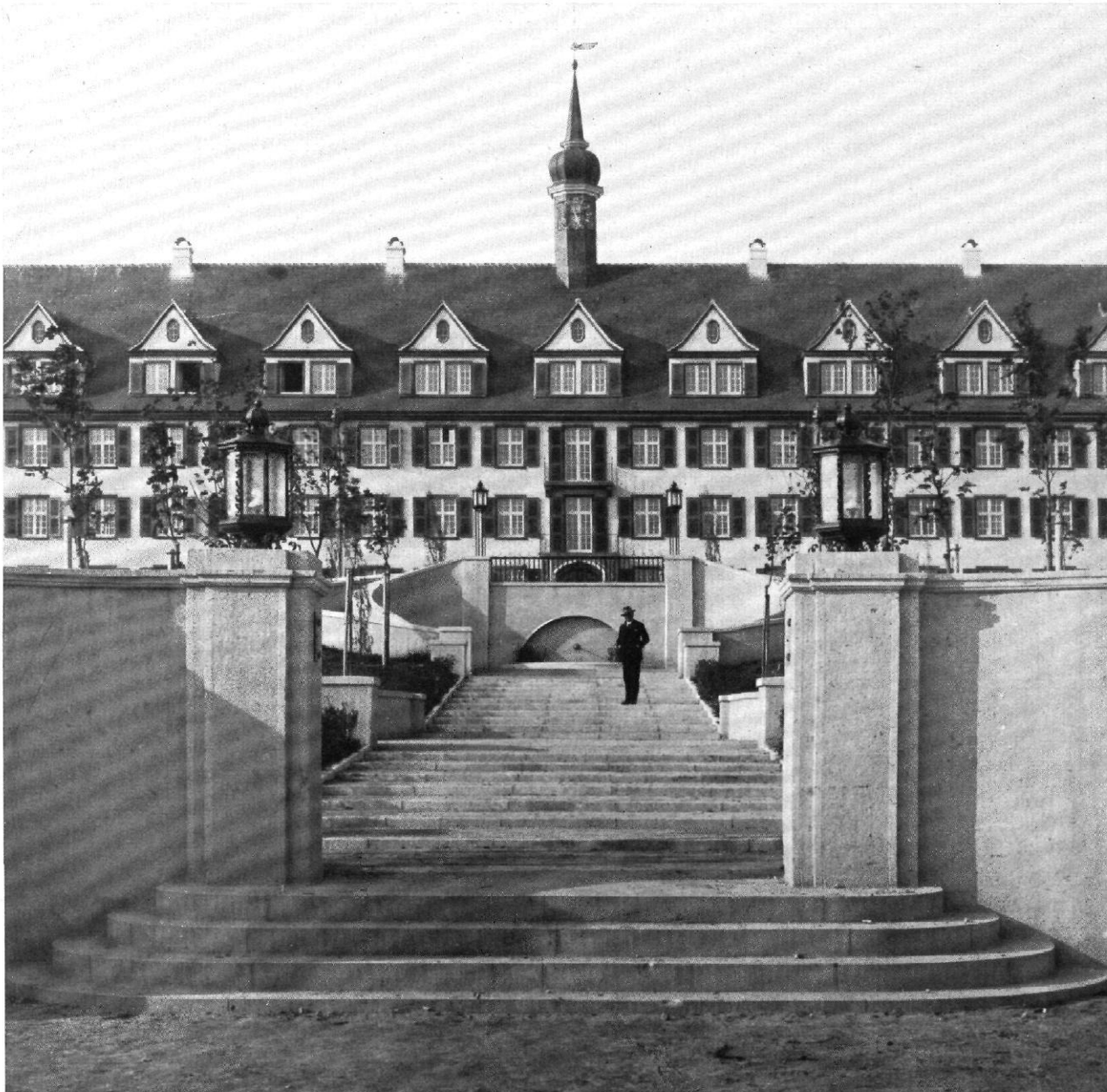
Abb. 3 / Erholungsheim der Eisenbahn-Betriebskrankenkasse Karlsruhe in Dürreim (Schwarzwald) / Haupteingang / vgl. Abb. 1 und 2
