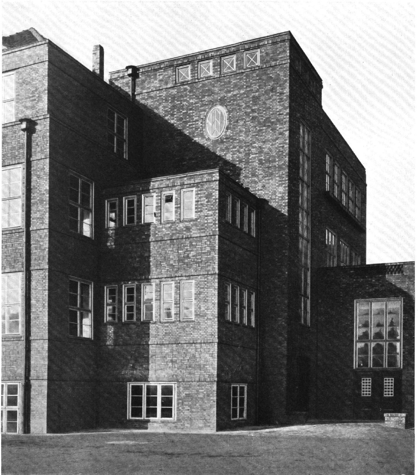
Abb. 21 | Hilfsschule in Eimsbüttel | Architekt: Fritz Schumacher, Hamburg | Teilansicht vom Hofe aus | Vgl. Abb. 22 und 23
