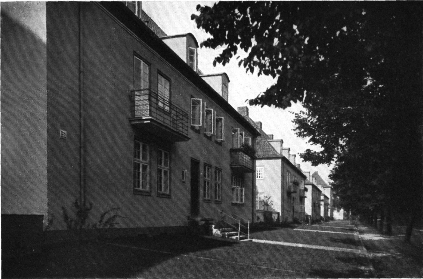
Abb. 1 | Wohnhausgruppe in Lichterfelde der Gagfah, Gemeinnützigen A.G. für Angestellten-Heimstätten, Berlin Architekt: Bruno Langkeit, Berlin unter Mitarbeit von Gerhard Doherr, Arthur Hübner bei dem Entwurf und Karl Rudolf Mitzkeit bei der Oberbauleitung
