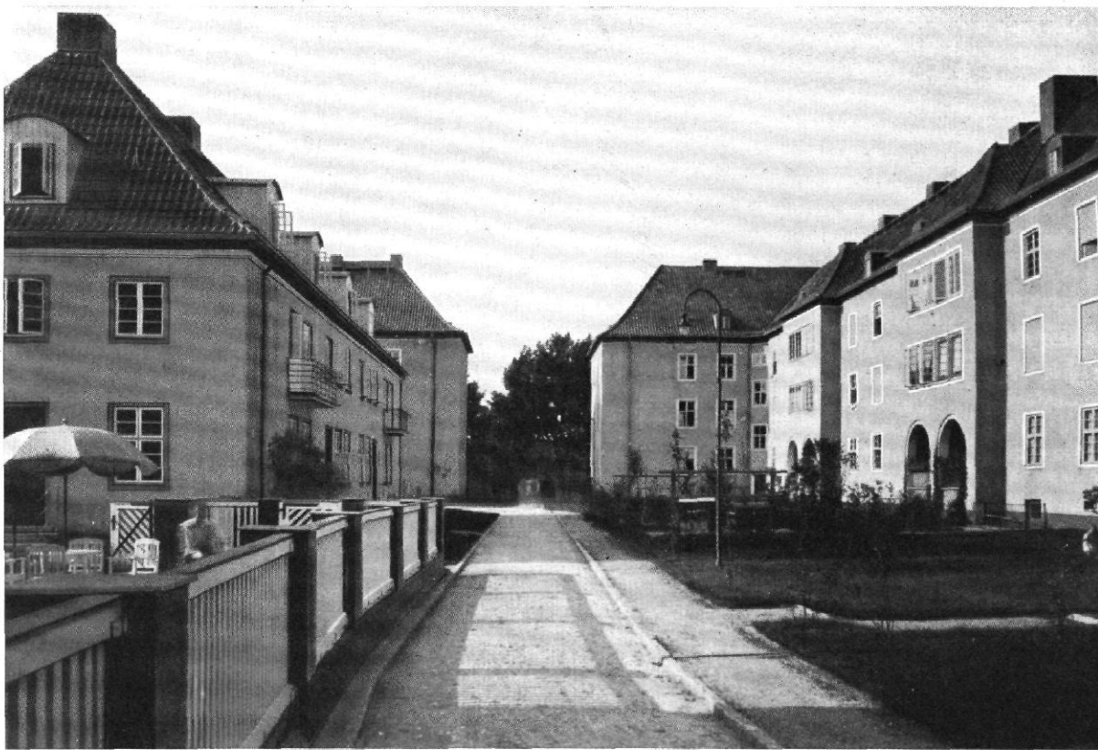
Abb. 15 und 16 | Wohnhausgruppe der Gagfah Gemeinnützigen A.-G. für Angestellten-Heimstätten, Berlin | Architekt: Bruno Langkeit, Berlin, unter Mitarbeit von Gerhard Doherr, Arthur Hübner bei dem Entwurf und Karl Rudolf Mitzkeit bei der Oberbauleitung
