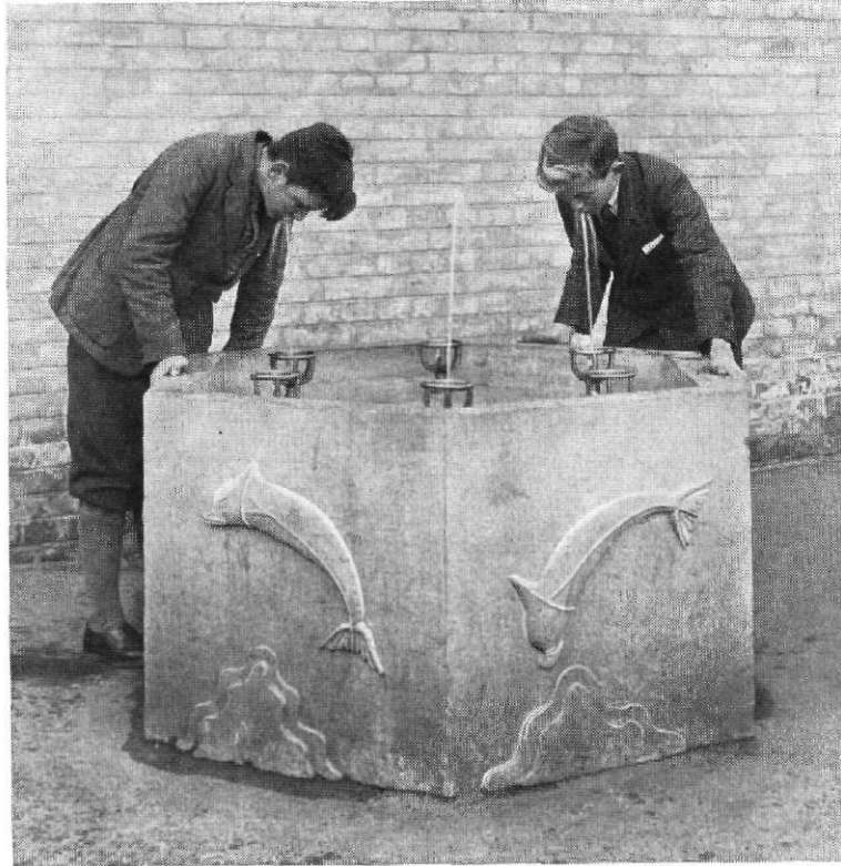
Abb. 17 | Staatsskule in Gjentofte, Dänemark | Trinkbrunnen im Schulhof | Architekten: Niels Hauberg und Edvard Thomsen, Kopenhagen | Bildbauer: O. Stahr-Nielsen
