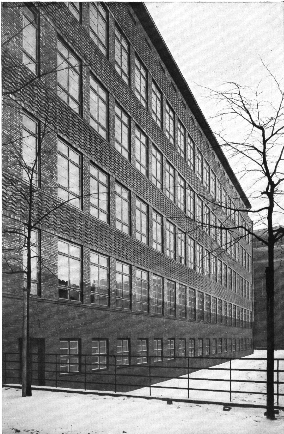
Abb. 5 / Berufsschule Angerstraße, Hamburg / Architekt: Fritz Schumacher, Hamburg / Südfront
